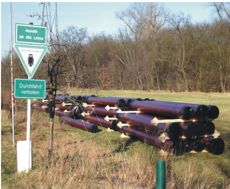
Insgesamt 2,5 Km neue Rohre
