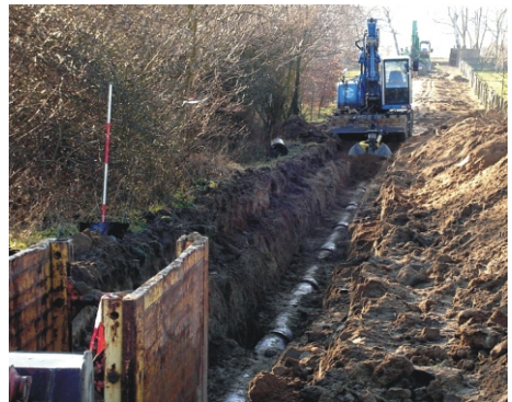
Die schmale Vorkopfbauweise
